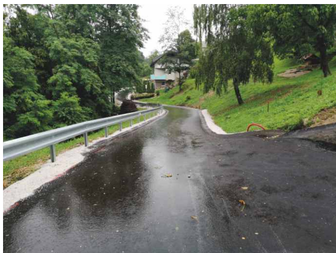
Rekonstrukcija JP - Tovarniška ulica
